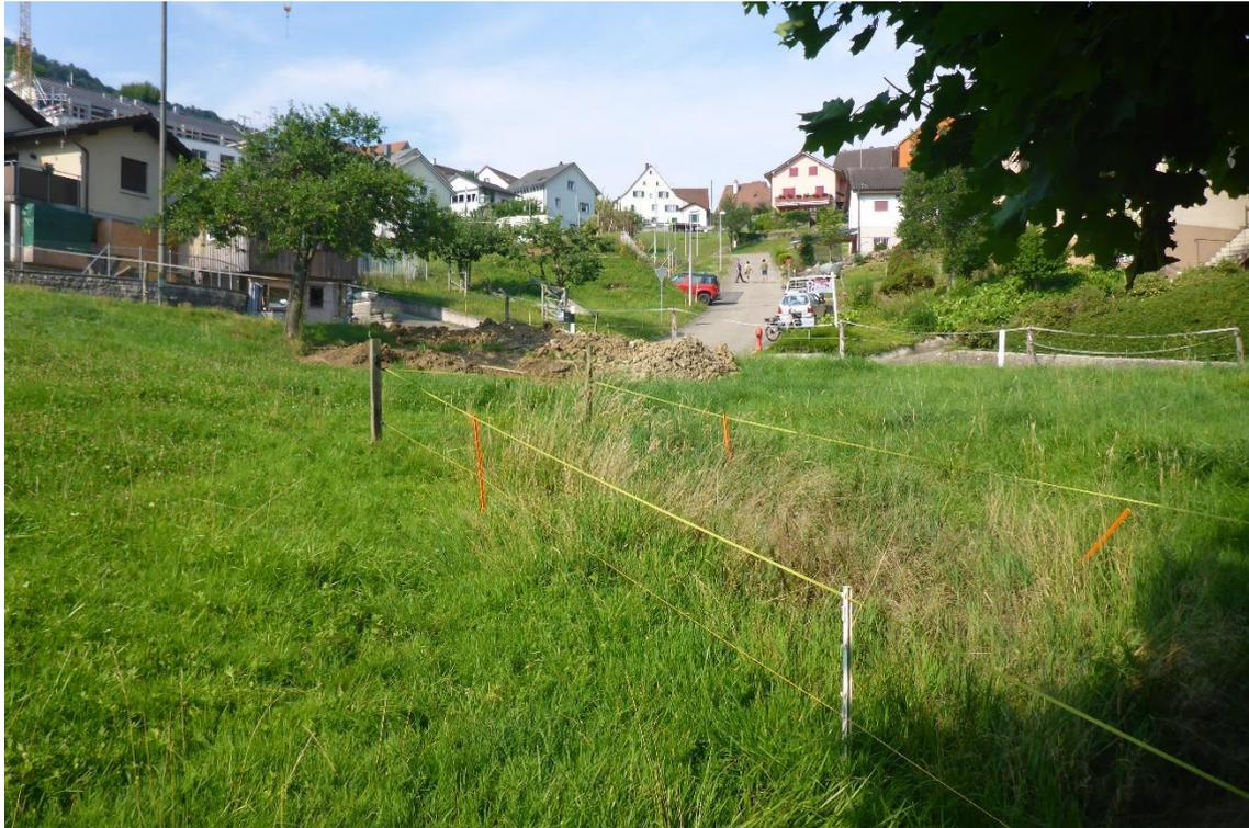
*Der Bereich unterhalb der Wahlenstrasse, die Eindolung wurde sondiert. Im vorderen Bildbereich ist die Vernässung, ausgelöst durch die defekte Eindolung zu sehen.*
