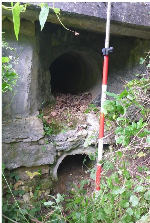
*Unterhalb Durchlass D1, das untere Rohr ist der eingedolte Dorfmattbach (dn40cm), das obere Rohr ist ein Notüberlauf für Oberflächenwasser (dn60cm).*
