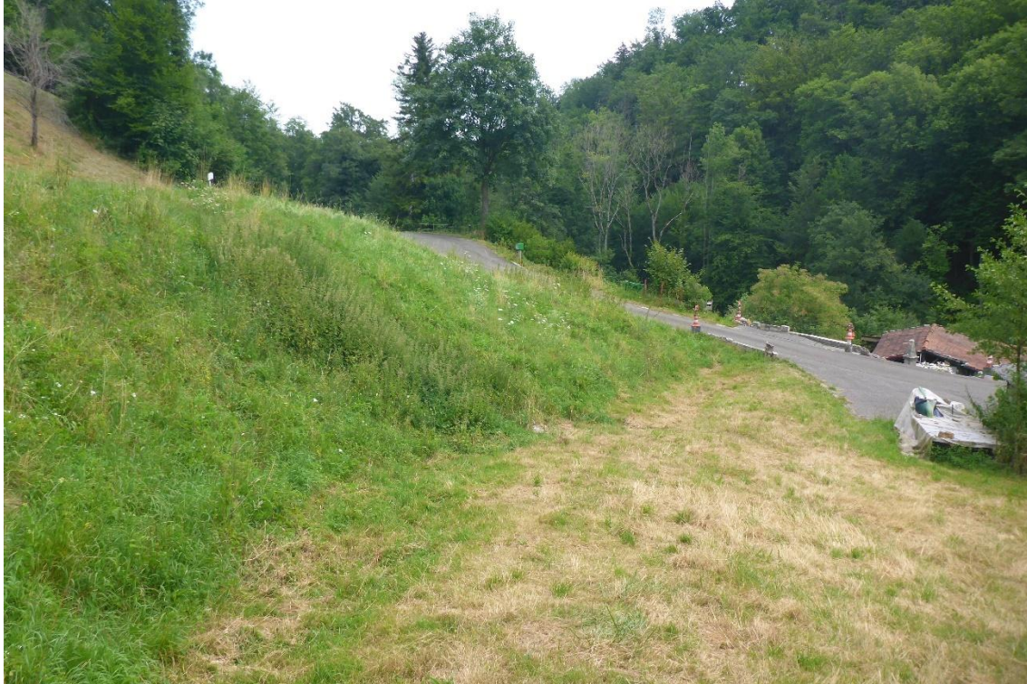
Blickrichtung bachabwärts auf Höhe der Parzelle 351, der Dorfmatzbach wird im Bereich des Böschungsfusses ausgedolt. Im unteren Bereich ist Querung D1 zu sehen.
