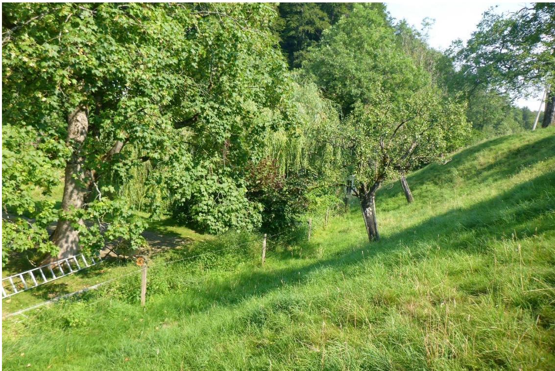
Blickrichtung bachabwärts auf Höhe der Parzelle 375, der Dorfmattbach wird im Bereich des Zauns ausgedolt.
